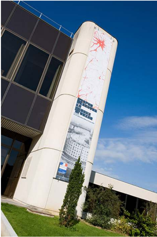
L'Unité n°1, détail de façade, 2010.
