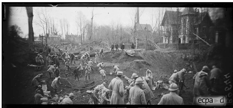
NOYON (OISE), LE BOULEVARD CARNOT DÉFONCÉ PAR LES MINES ALLEMANDES. SOLDATS DU GÉNIE TRAVAILLANT AU RÉTABLISSEMENT DE LA ROUTE.
