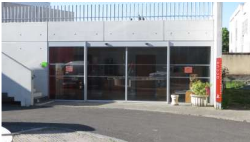
Figure 1 : Façade du Centre de la mémoire
