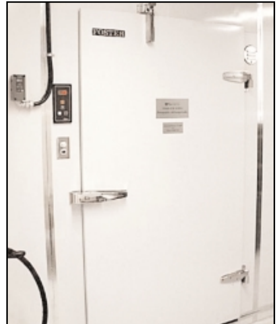
Figure 13. Le congélateur avec ses joints scellés à l'aide de ruban d'aluminium adhésif et son panneau d'alarme (lumière rouge).
