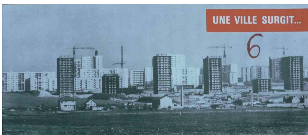
Chantiers du cardinal, diocèse de Paris. Plaquette d'information avec chantier de Créteil (1962-1963) Phot. S. Neville. 2009. © CNAEF, 23 CO 2
