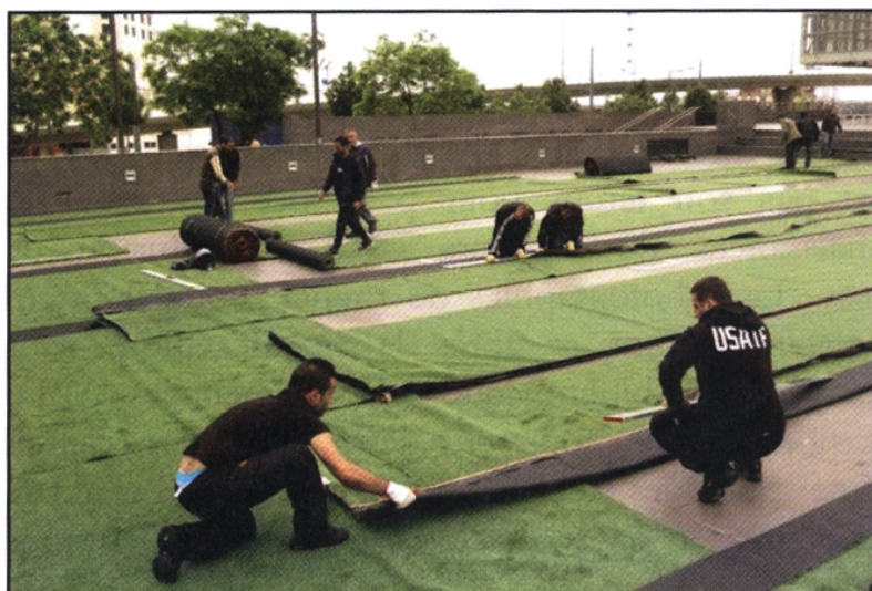
Installation de la pelouse synthétique sur le parvis Gaston-Defferre des Archives et de la bibliothèque départementales des Bouches-du-Rhône, 16 mai 2013 © David Fauci
