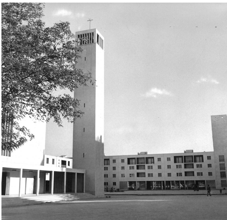
Pierre Vago, reconstruction de l'église Saint-Pierre, faubourg de Trinquetaille à Arles (Bouches-du-Rhône), 1953 : vue d'ensemble
