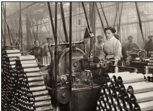
Usine Panhard & Levassor de l'avenue d'Ivry, 13 e arrondissement, Paris, 1915 © FDMHI
