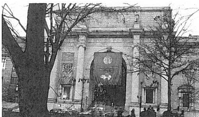
Niveau 5 : un musée centenaire situé sur la grande place d'une ville.
