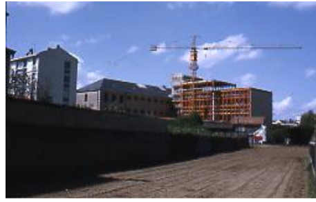
Archives de la Sarthe, extension en construction (juin 1973) © Gérard Naud (autorisation Archives départementales de la Sarthe)
