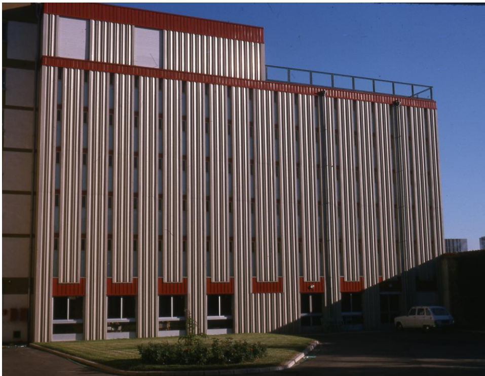
Archives de la Sarthe, nouveau bâtiment (1976) © Gérard Naud (autorisation Archives départementales de la Sarthe)
