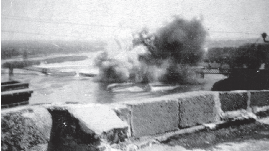
Illustration 1. Le viaduc ferroviaire de Saumur, inauguré en 1886 et long de 1 050 m, explose et semble tomber dans la Loire, photographie, date précise inconnue (entre 1944 et 1946), Cliché d.r., coll. privée.
